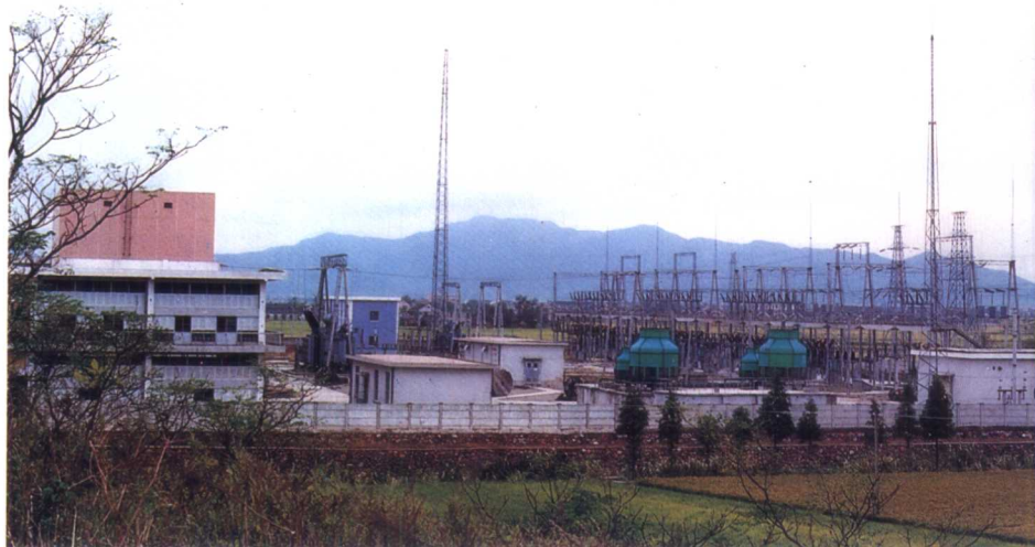
容量为5万千瓦的 100千伏大碛整流站
