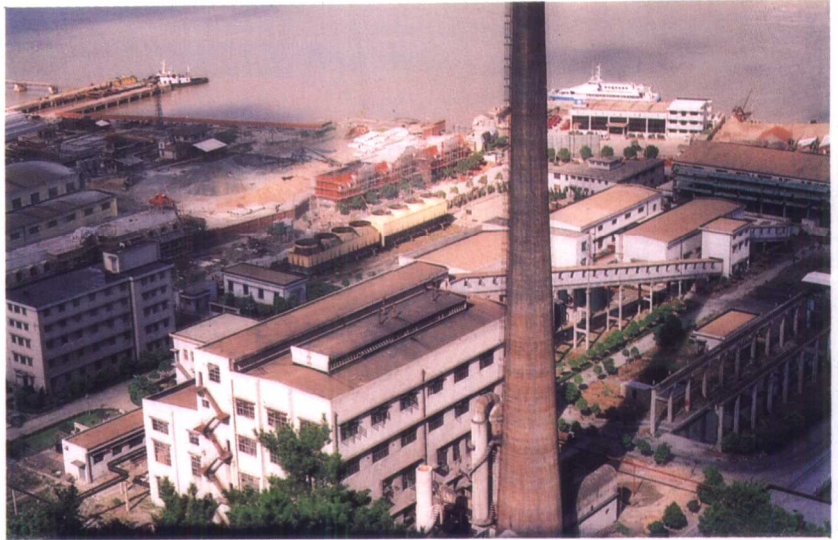
经济技术开发区热电厂全貌
