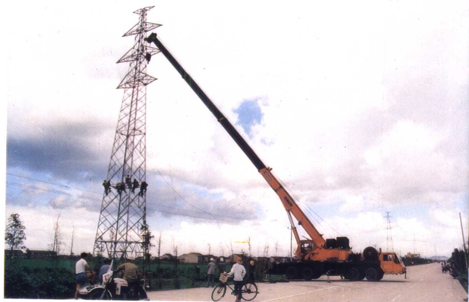
宁波电业工人在吊装220千伏铁塔
