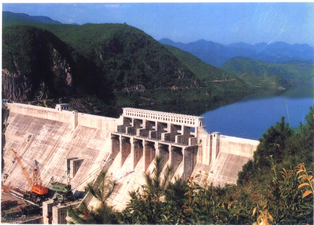
装机总容量 4000 千瓦奉化亭下水库电站
