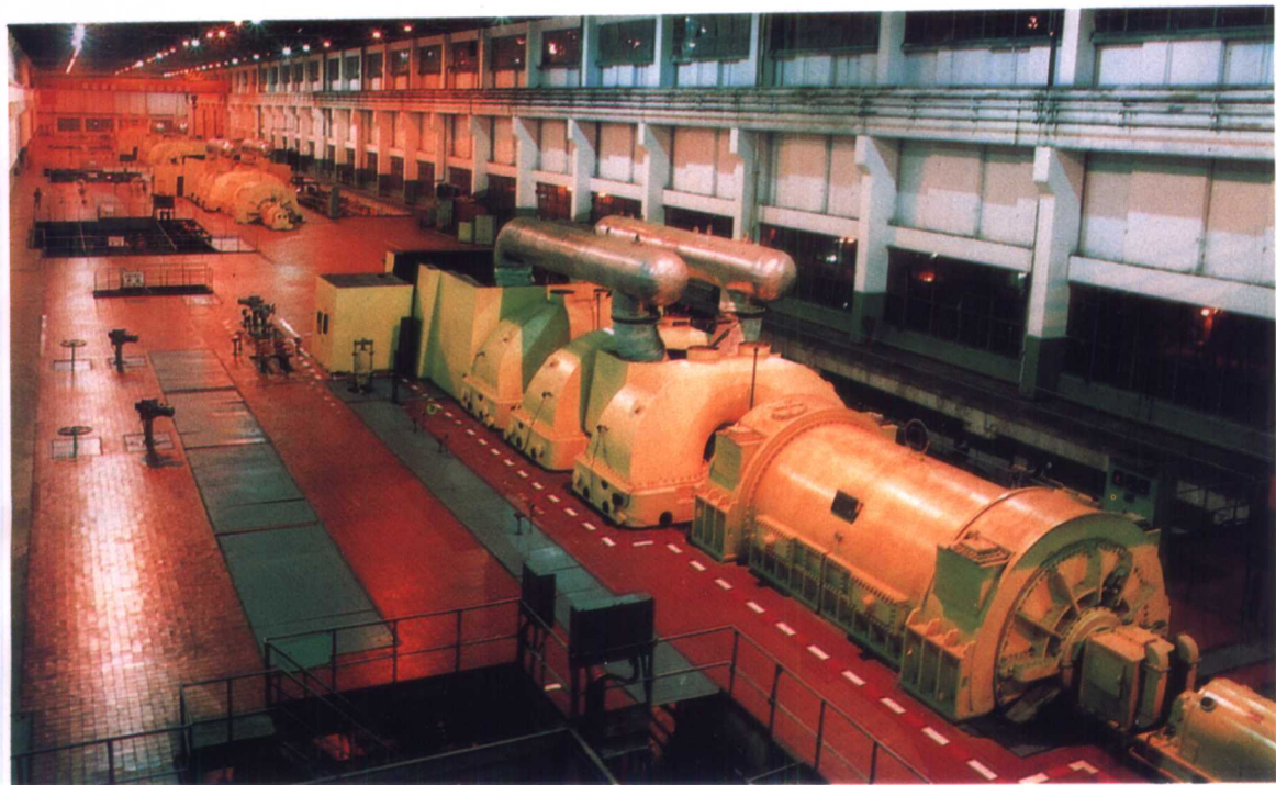
镇海发电厂 20 万千瓦汽轮发电机组
