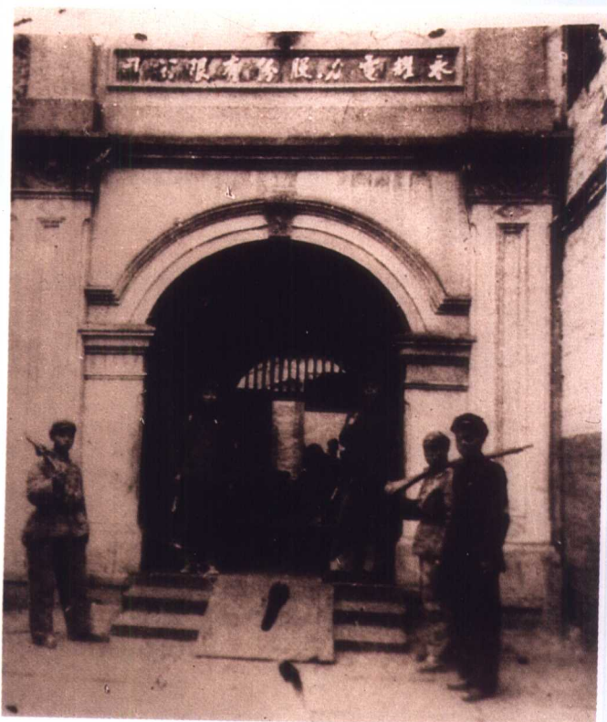
宁波解放初永耀电力公司发电厂大门
