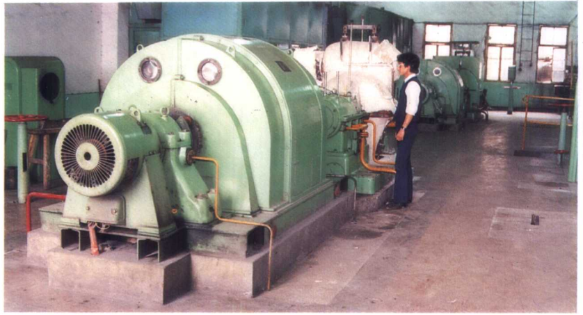
余姚棉纺厂热电站 1500 千瓦汽轮 发电机组
