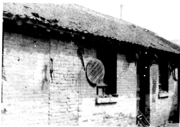
新甸铺保卫战遗址——一区区公所
