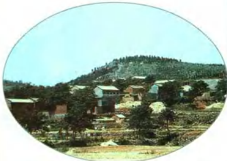
林州人民惜土如金。从当地的实际情况出发，在村庄建设上坚持走旧村改造的道路。图为农民群众把房屋建在山坡上，腾出平地造良田
