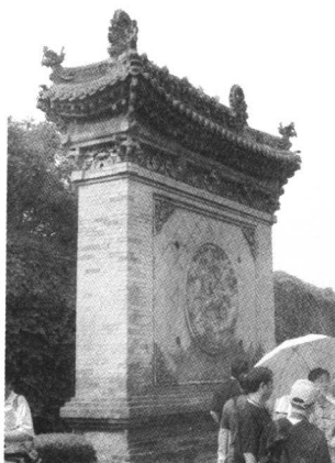
图1-13 中国历史民居中的磨砖对缝清水砖墙。山西乔家大院
