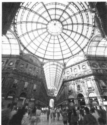
图1-8 利用钢结构玻璃幕穹顶技术将历史建筑联结起来形成舒适的室内步行空间。意大利汪贝鲁一世风雨商业街
