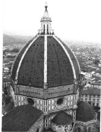
图1-6 佛罗伦萨圣玛丽亚大教堂穹顶(The Domw of S.Maria del fiore,1420—1434年)。伯鲁乃列斯基设计,内径42m,高30余米
