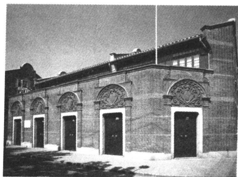
图 1-16 中西合璧建筑中的清水砖墙。上海
