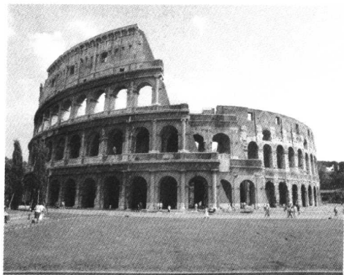
图 1-23 罗马大斗兽场(Colosseum, 公元 70—82 年),采用混凝土筒形拱和交叉拱。意大利罗马
