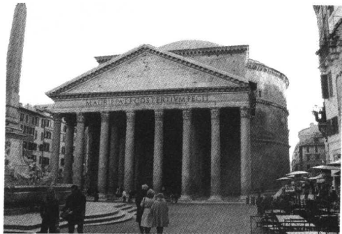
图 1-21 罗马万神庙的混凝土穹顶(Pantheon 120—124年),穹顶直径43.43m,底部厚度6.2m,顶部中央开设直径8.23m的圆洞。意大利罗马
