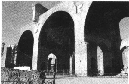
图 1-25 古罗马的公共浴场(thermae),拱券为混凝土结构。意大利罗马
