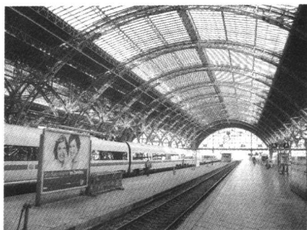
图1-11 德国莱比锡火车站的大跨度钢结构拱顶
