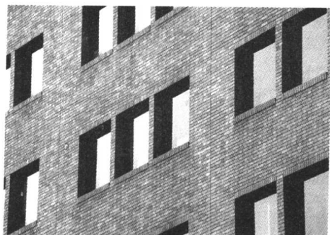
图 1-15 现代建筑中简洁明快的清水砖墙
