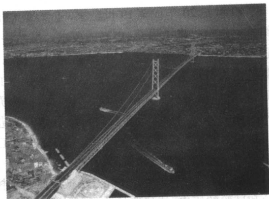
图 1-12 日本明石海峡桥
