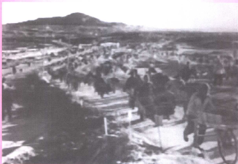
黄壁庄水库建设工地
