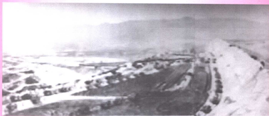
施工中的西大洋水库
