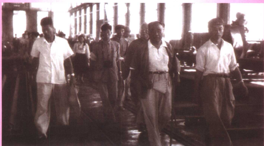
1954年8月朱德视察山海关桥梁厂
