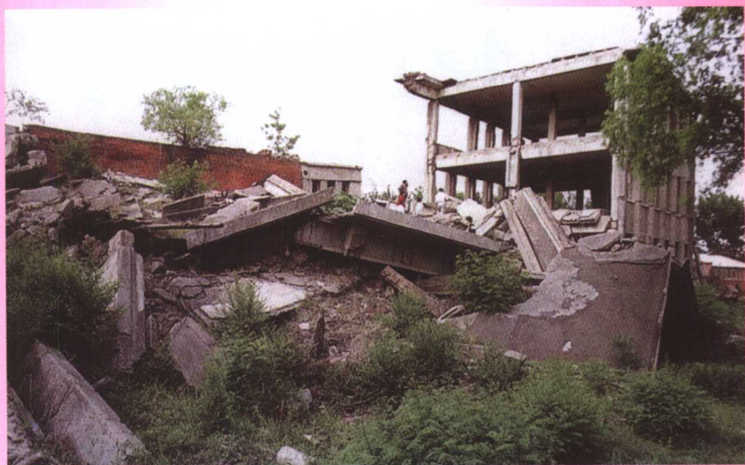
1976年唐山地震废墟一角
