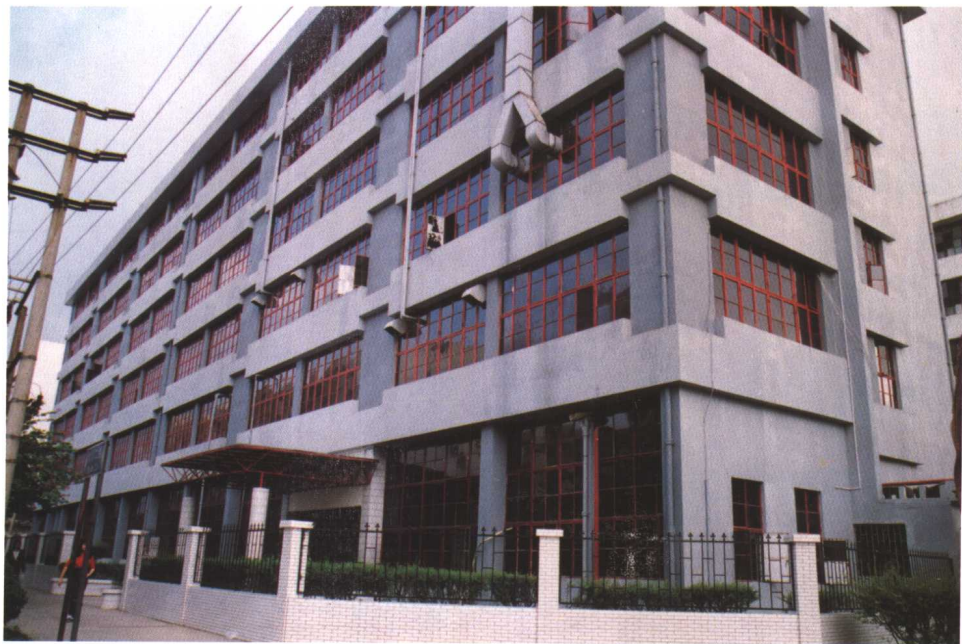
◎ 朴素的水贝工业大楼
