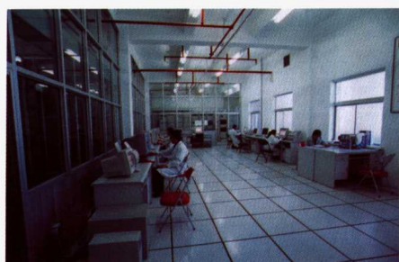
交换传输机房工作人员
