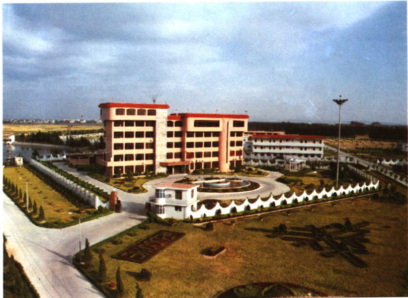
石狮 20 万吨自来水厂全景
