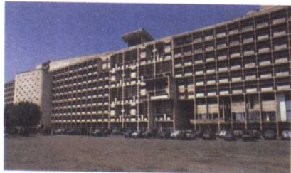
政府综合大楼中间部位的长官办公区（印度昌迪加尔）
