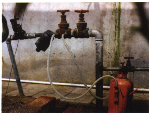
有机生态型无土栽培设施的供液主管上安装有文丘里式施肥器和过滤器
