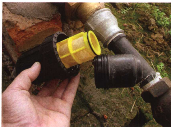
安装在供液主管上的滤网式过滤器
