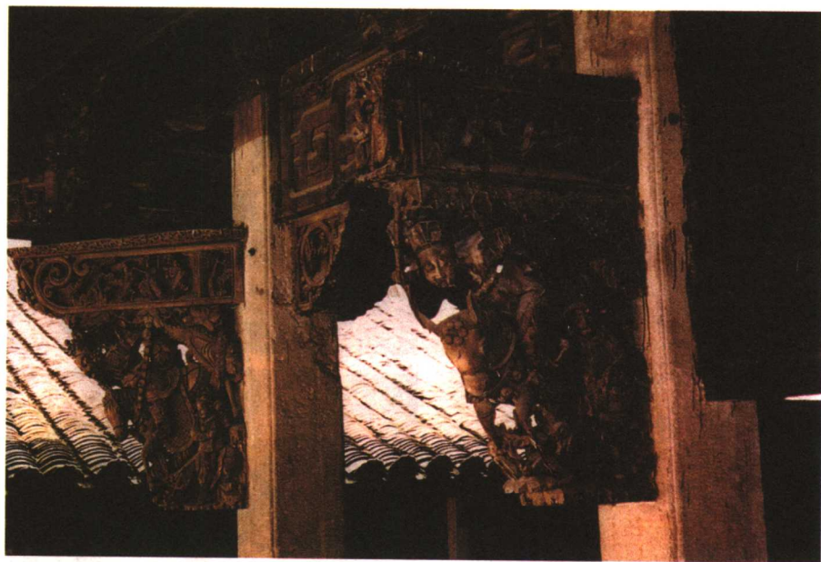
浙江兰溪县诸葛村祠堂梁架牛腿
