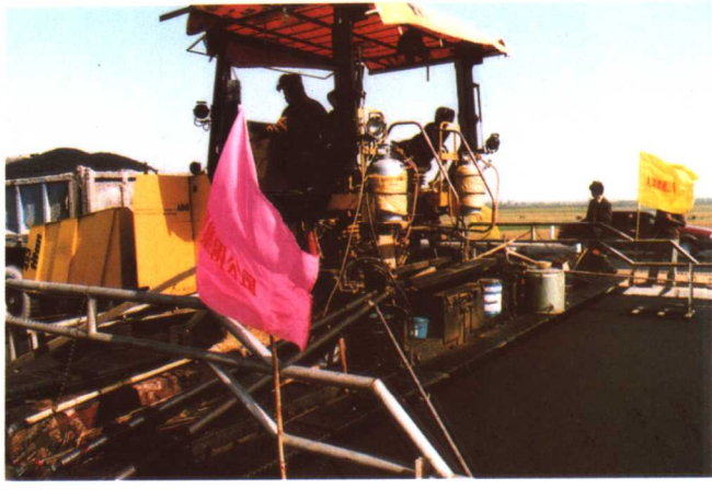
德国产 ABG423 型推铺机正在安新高速公路施工
