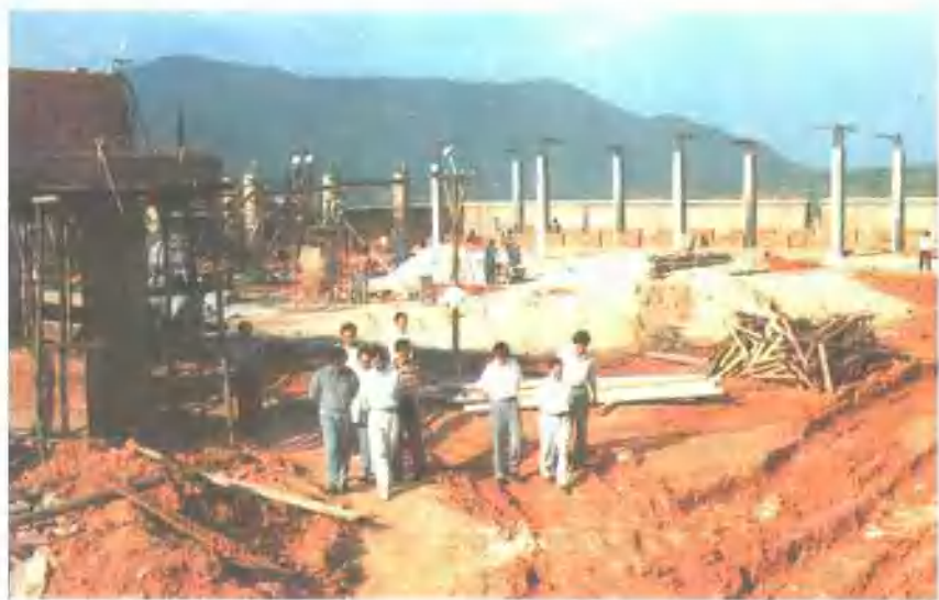
▲ 正在建设中的 110 千伏县城中心变电站
