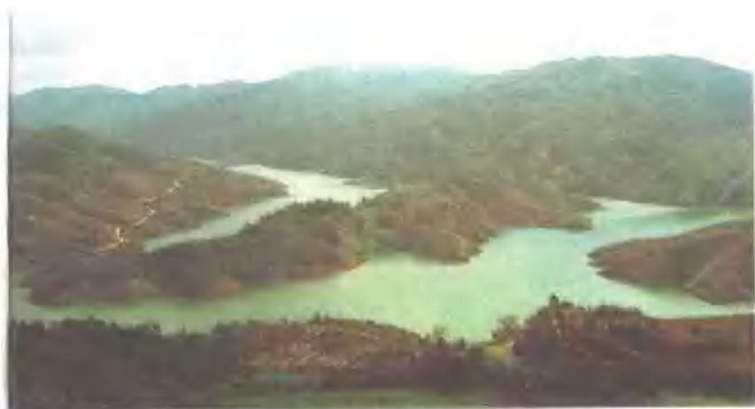
▲ 新平高草坝水库库容3460万立方米，为宜溪地区第二大水库。图为水库部分水域远眺
