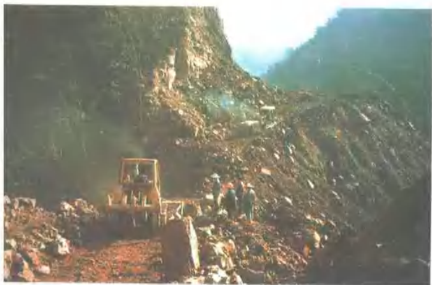
▲ 劈山开路——新细公路峨德河段开挖情景
