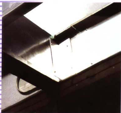
图1.2-5 安装在木材骨架墙上的冷轧钢(CFS)楼层托梁和导轨(参考详图 No.F1、No.F2 和 No.F3)
