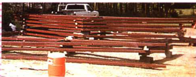
图 1.3-16 装配好的尖屋顶骨架
