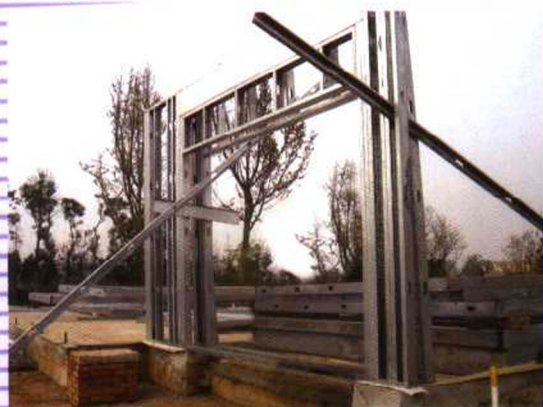
图 1.1-13 临时支撑墙骨架
