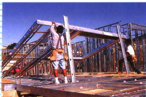
图 1.1-6 竖起墙骨架
