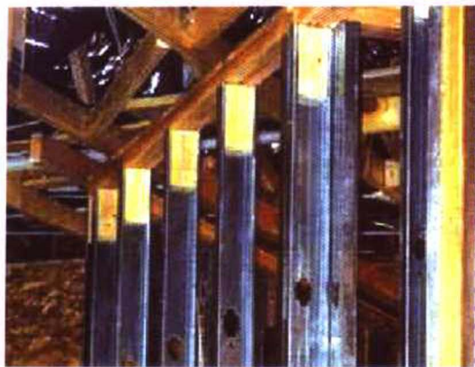
图 1.2-10 冷轧钢(CFS)墙与木材顶板 (参考详图 No.W1a)
