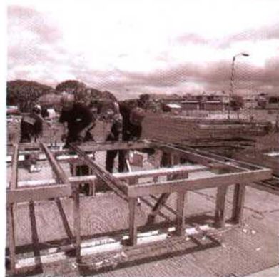
图 1.1-5 在施工现场组装墙骨架
