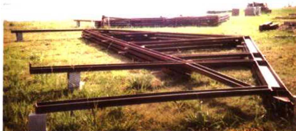
图 1.3-15 装配好的尖屋顶骨架
