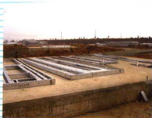
图 1.1-8 把在附近组装好的墙骨架运到混凝土基础平台上
