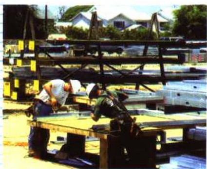
图 1.1-4 在施工现场组装墙骨架
