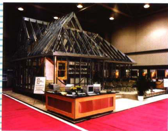
图 1.1-9 椽架尖屋顶骨架
