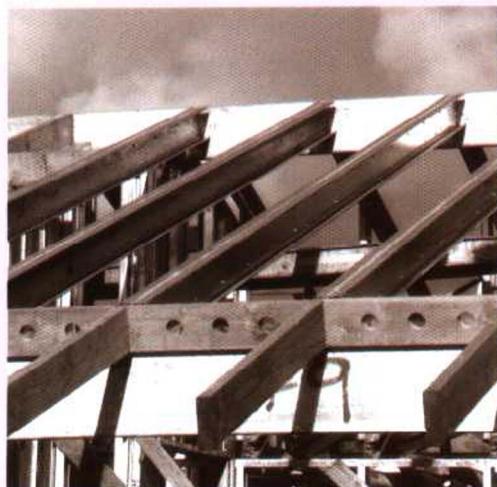
图 1.2-2 拼接在冷轧钢(CFS)屋椽里的木材挑檐 (参考详图 No.R1、No.R2、No.R3 和 No.R9)
