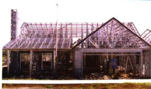
图 1.1-10 桁架尖屋顶骨架
