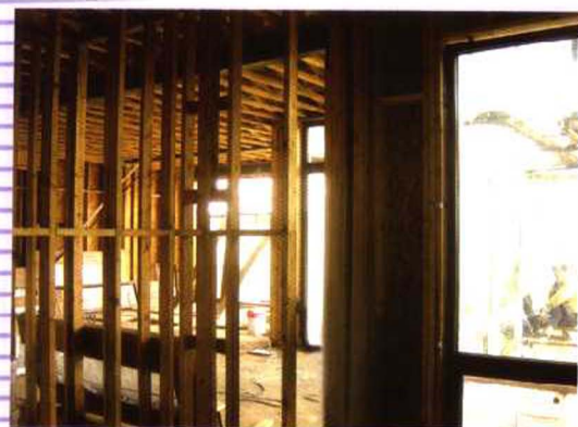
图 1.2-13 木材骨架住宅里采用钢制大梁
