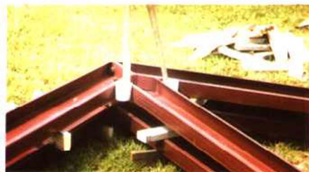
图 1.3-17 准备吊起尖屋顶骨架
