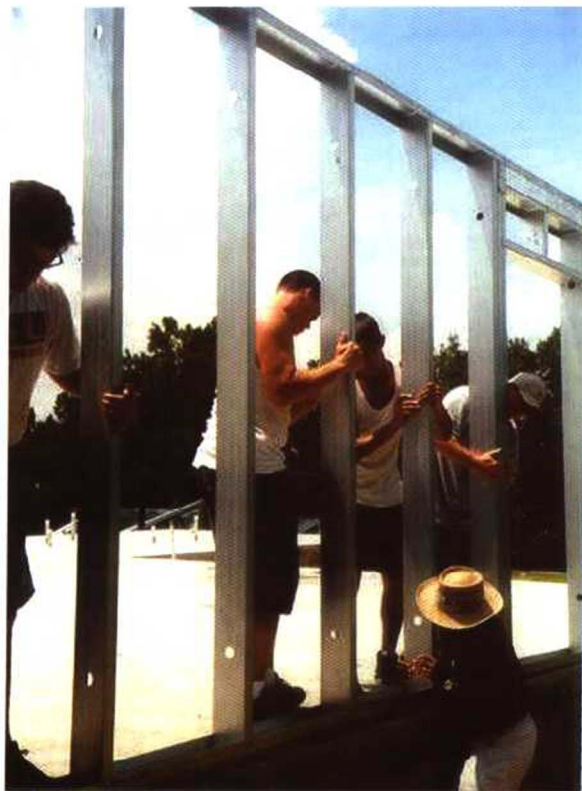
图 1.1-7 在现场把墙柱安装到底部导轨里
