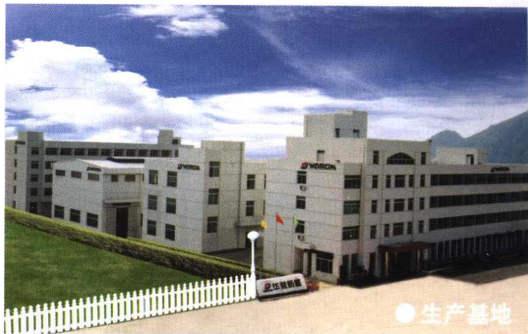
● 集团公司上海防爆工业园区
