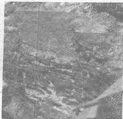
图 1-9 故宫北上門柱基下 面的磚与土。
