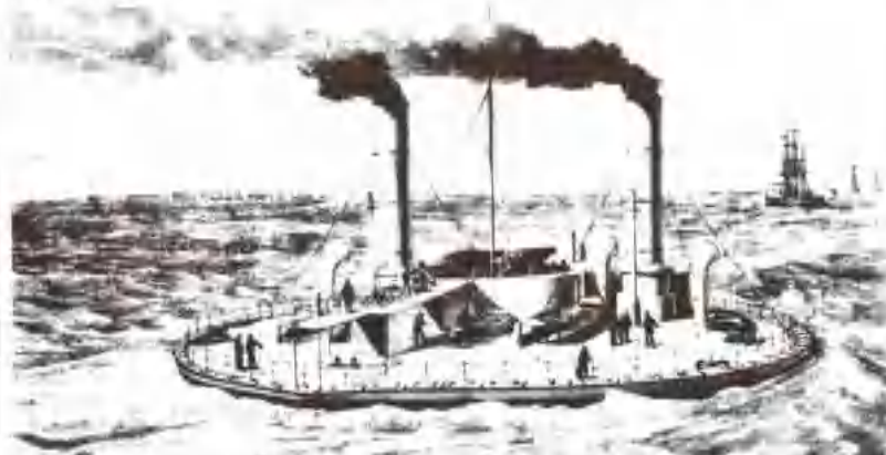
俄国在19世纪70年代设计的圆形铁甲舰已经使用蒸汽机作为动力,但航速仍很慢。
