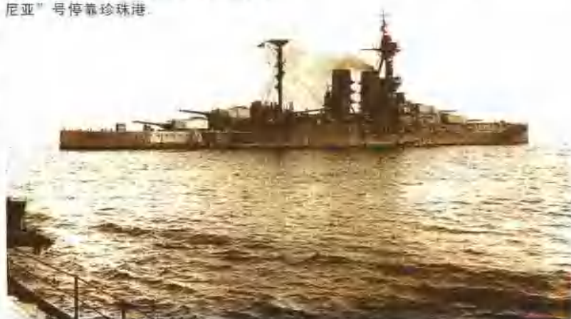
在英国战列舰“沃尔斯派”号上，可以看到早期的对抗措施，锯齿形的帆布条挂在烟囱上，用以伪装外形，并迷惑敌人，使其测距仪难以准确测定其目标的位置和路线。
