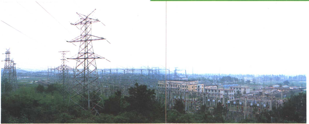
全省第一座 500 千伏瓶密变电所全景
