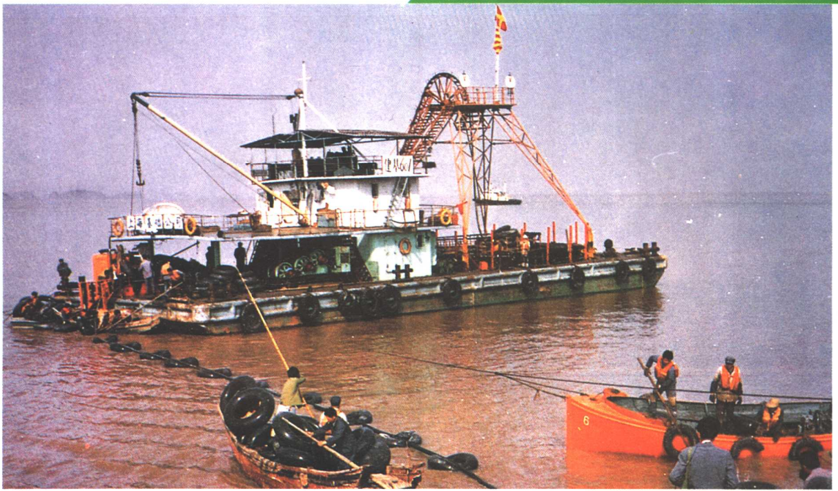
100 千伏舟山直流输电工程海底电缆敷设
