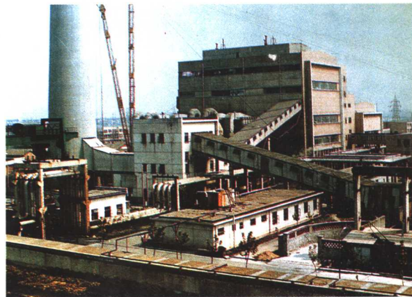
联片供热——杭州热电厂
