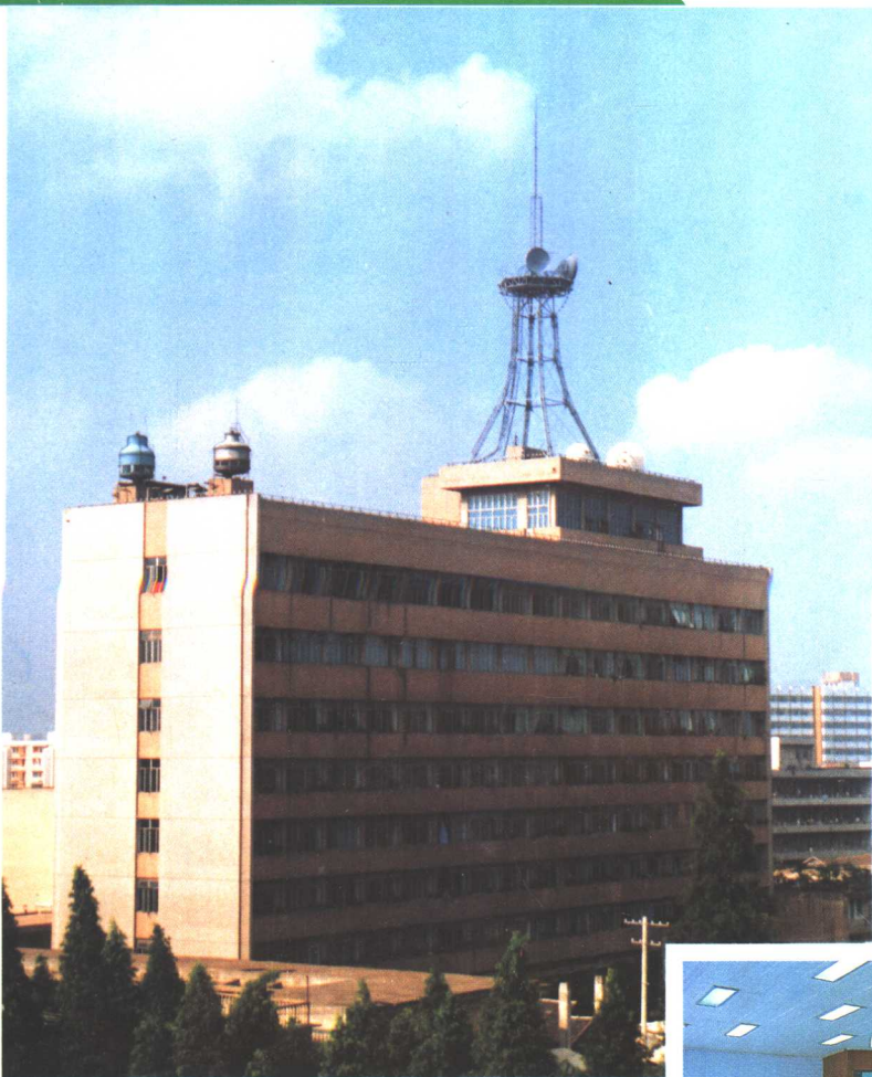
浙江省电力调度大楼
