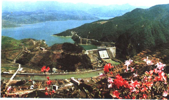
新昌长诏水电站
