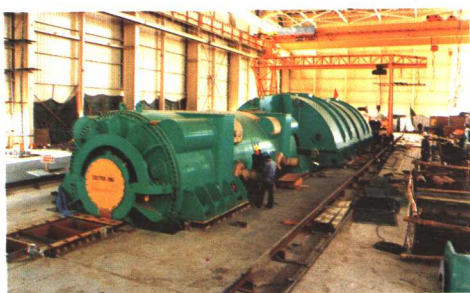
安装中的北仑港发电厂 60 万千瓦汽轮机
