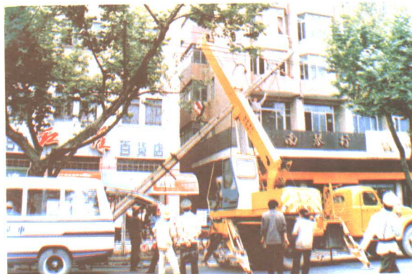
杭州市电力局职工抢修被台风毁坏的城市线路
