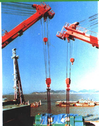
北仑港发电厂工程建设中 300 余吨重的发电机定子卸船
