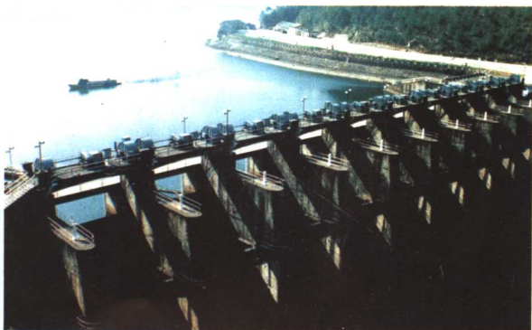
黄坛口水电站
