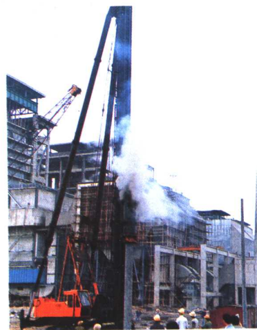
1986 年 11 月 13 日镇海发电厂三期工程打下第一根钢筋混凝土桩
