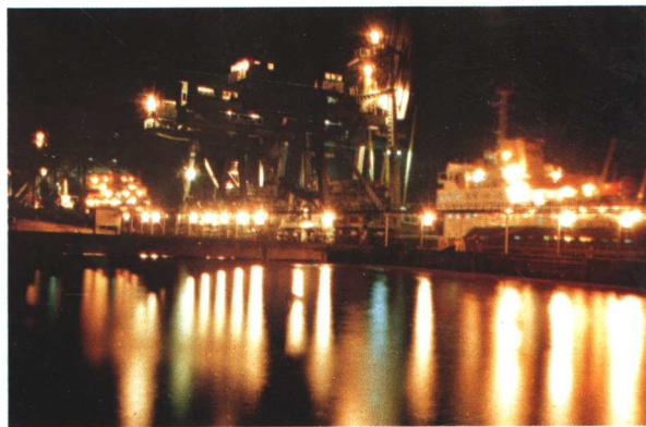
台州发电厂万吨级煤码头
