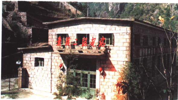
缙云盘溪梯级水电站(二级电站)
