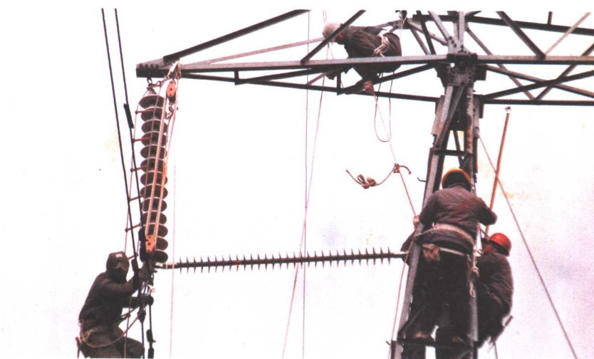
衢州电力局在 220 千伏新龙输电线路带电调换成绝缘子
