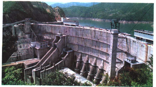
紧水滩水电站三心双曲变厚混凝土拱坝
