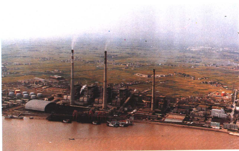
装机容量为 105 万千瓦的镇海发电厂
