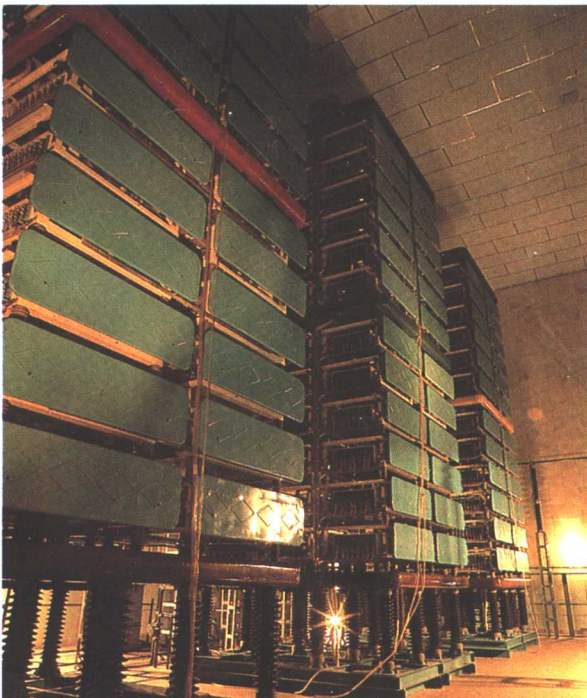
舟山逆变站 KGGS-500/100 型晶体管双重阀
