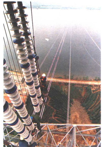
500 千伏北瓶线建设
