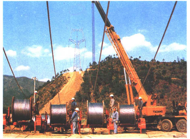
500 千伏密南线张力放线
