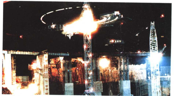
石塘水电站建设工地施工夜景
