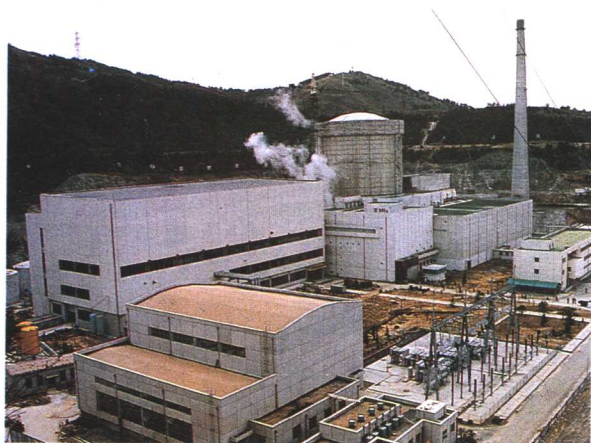
秦山核电站全景
