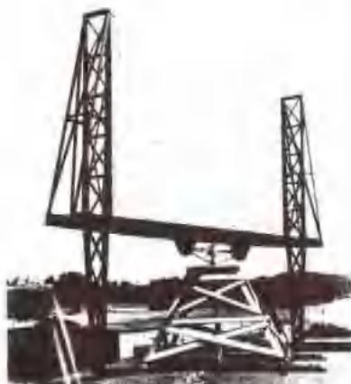
20世纪30年代末在美国阿纳考斯提亚海军研究中心建筑顶上安装的第一台定向雷达。
