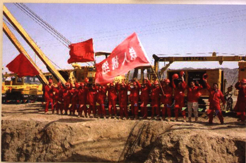
历史性的时刻—— 2004 年 8 月 3 日，西气东输全线管道焊接在甘肃完工。 《中国交通年鉴》 管道分部供稿
