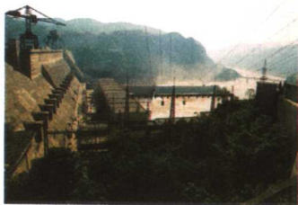
图2 1957年在三门峡建起高106米，长875米的拦河大坝，使高峡变成了平湖。
