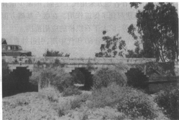
图6 伸臂石梁桥—大理观音堂桥
