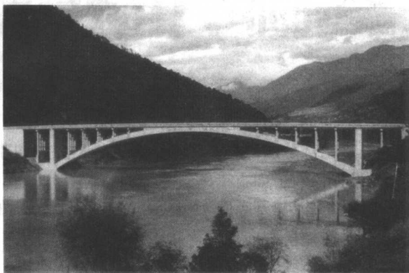
图 15 松园金沙江大桥
