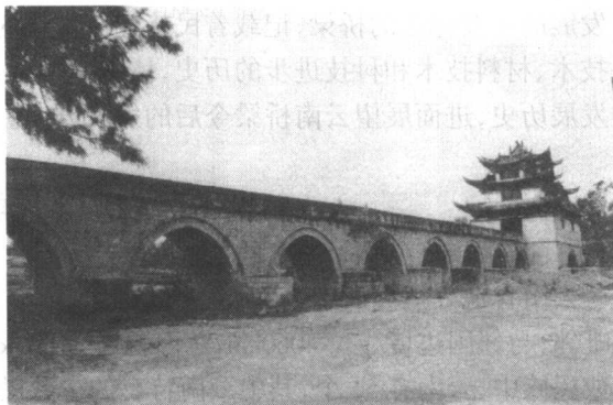
图 2 我国大型古桥之一建水县双龙桥(17 孔桥)
