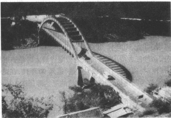
图 10 云南最大跨径( 80\text{m} )的钢筋混凝土下承式肋拱桥—跨越澜沧江的永保桥
