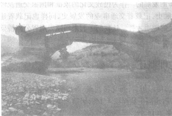
图 1 伸臂木梁桥—云龙县通京桥
