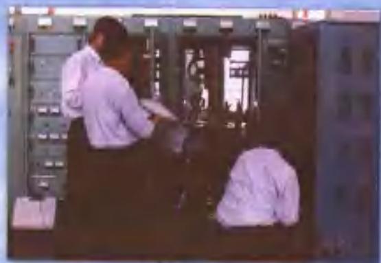
维护人员检修机房设备
