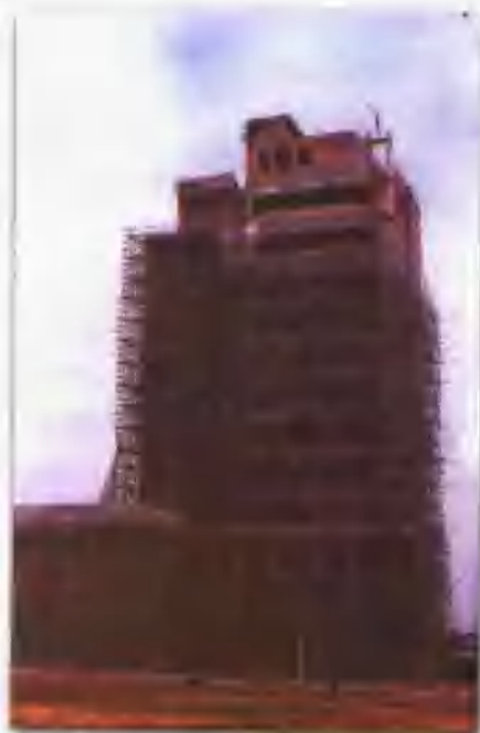
正在装修的广播电视大楼
