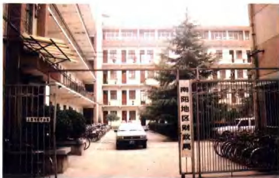
1987 年竣工的南阳地区财政局办公大楼
