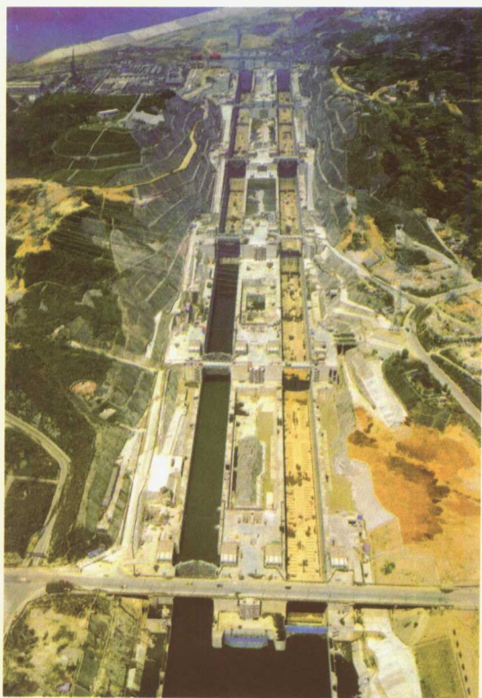
经过8年建设的三峡永久船闸，2003年6月13日试航，是目前世界上规模最大、级数最多、水头最高、技术最复杂的船闸。
