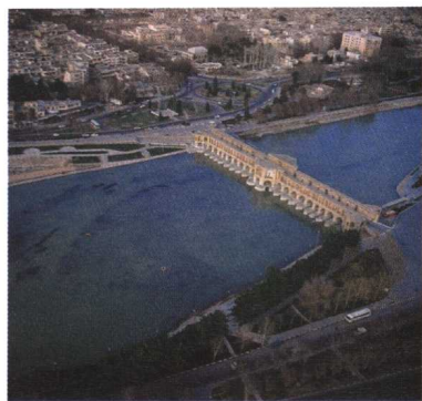
伊斯法罕哈珠大桥
