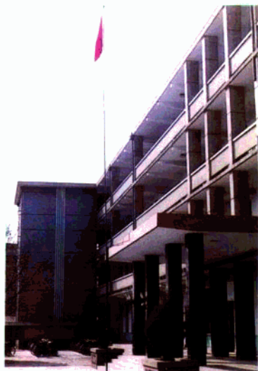
洛宁第一高中教学楼一角
