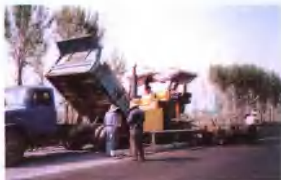
2000年开封至尉氏公路改善工程沥青路面施工，德国产ABG-422型摊铺机在作业
