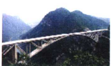
贵州江界河大桥
