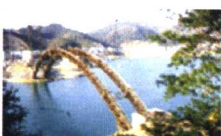
威坪钢管拱桥
