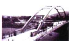
四川旺苍县东河桥
