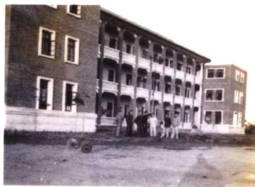
刚竣工的学院教学大楼
