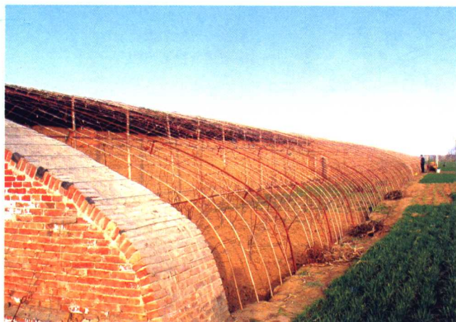
C型—焊接桁架 —琴弦式结构
