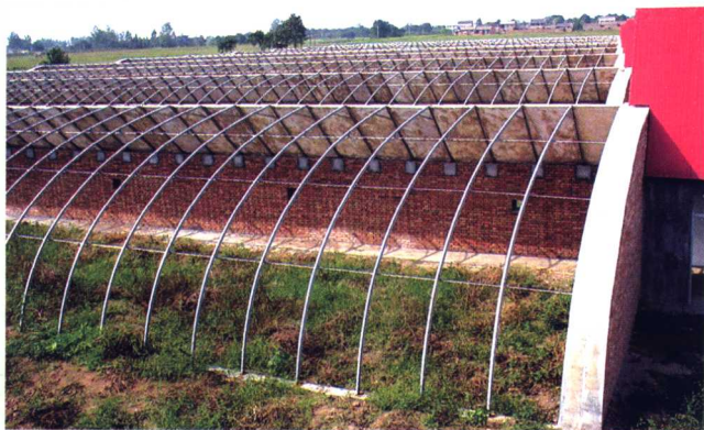
D型——外卷 边C型钢单管 骨架
