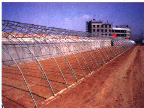
A型——热浸镀锌 钢管组合拱架结构
