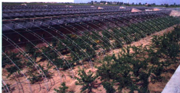
A型——热浸镀锌 钢管组合拱架结构
