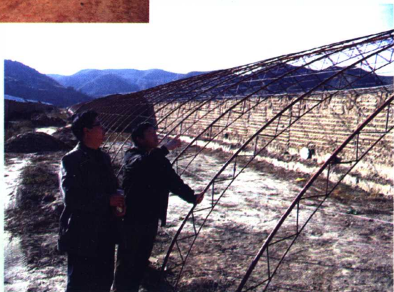
B型——焊接 轻钢桁架结构
