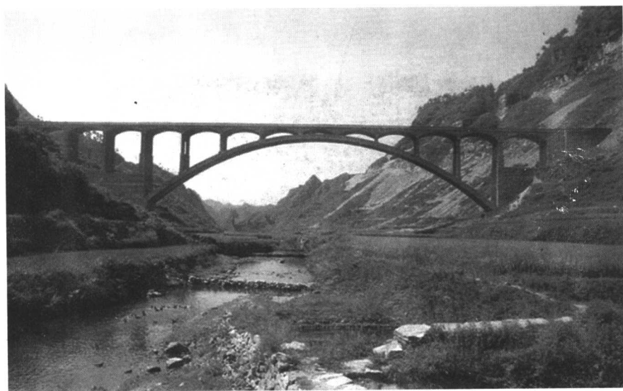
图 1-4 鸟巢河石拱桥(主跨 120m)
