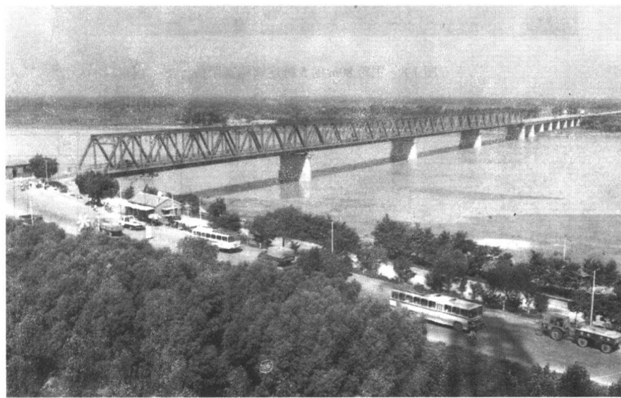
图 1-11 北镇黄河公路桥
