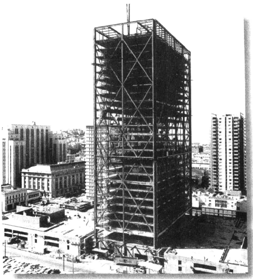
这座高耸的建筑物上的菱形框架用来承受地震 载荷（照片使用承蒙 Bethlehem Steel 准许）
