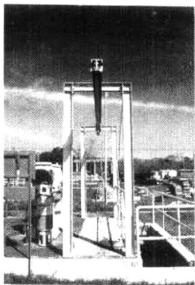
图 1.7 刚架中的杆件承受轴力、剪力和弯矩作用
