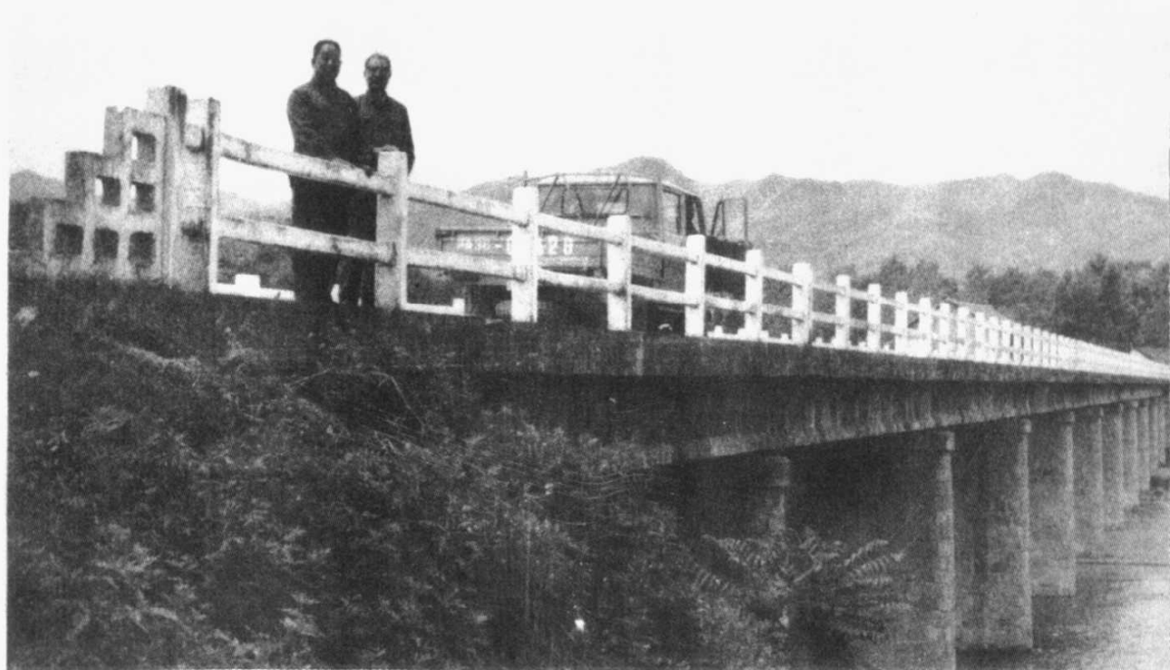
鲁山赵村工字梁微弯板桥
