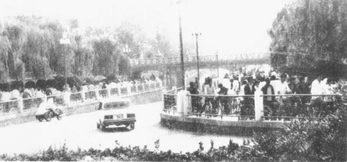
许昌市京广铁路立交桥
