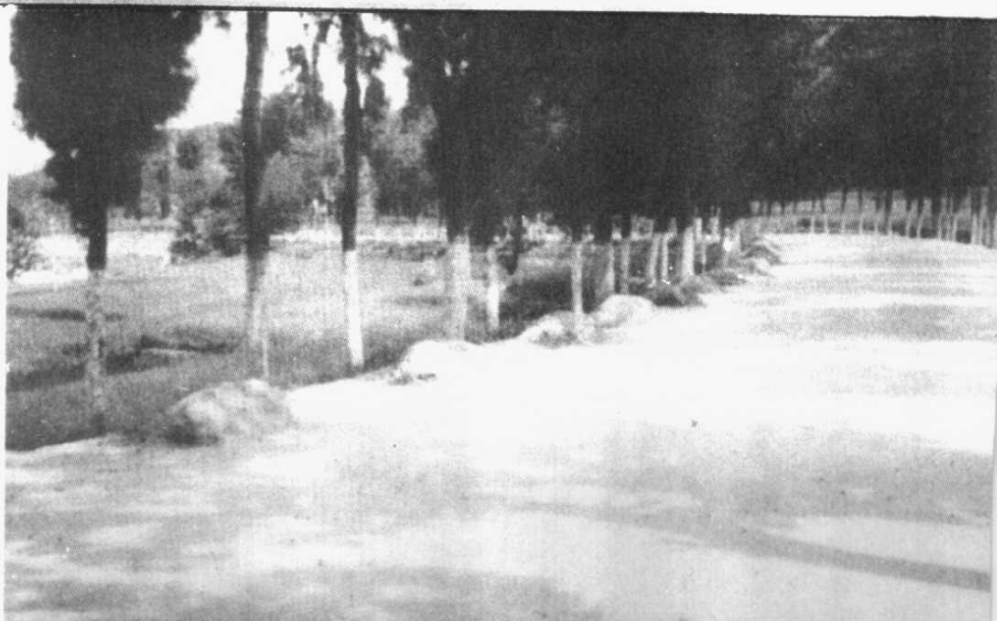
庙鲁线砂石路面
