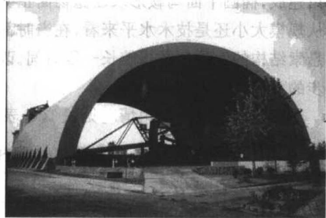
(b) 河南南阳鸭河口电厂干煤棚
