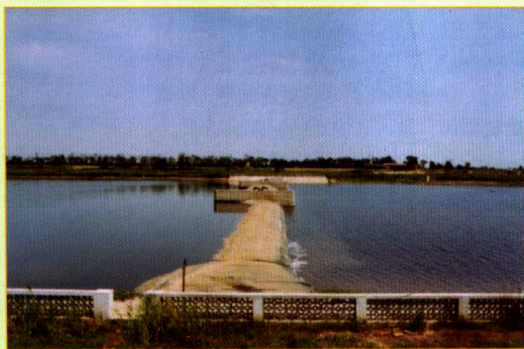
● 区财政投资2480万元修建的大型农田水利设施——永定新河深槽蓄水工程,它解决了我区5个镇农田的灌溉问题。
