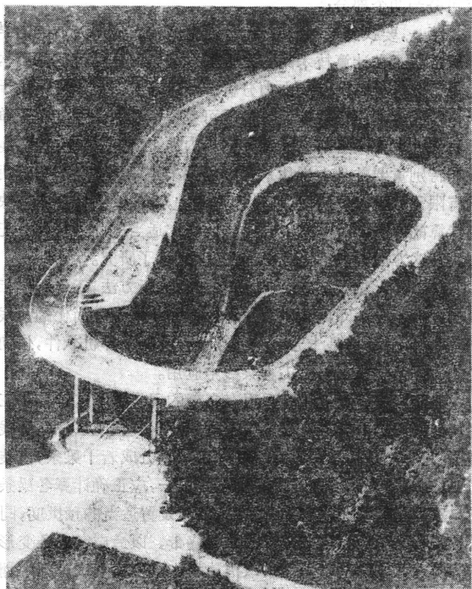
图 1-3 山区公路中的曲线梁桥
