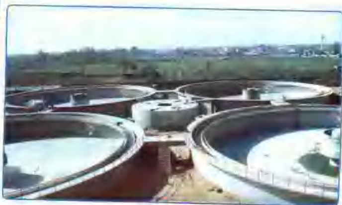
▲正在施工中的南阳市污水处理厂一瞥
