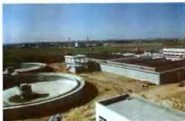
▲刚竣工的南阳污水处理厂主体工程
