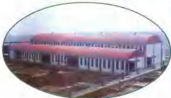
▲正在施工中的南阳市垃圾处理厂一角
