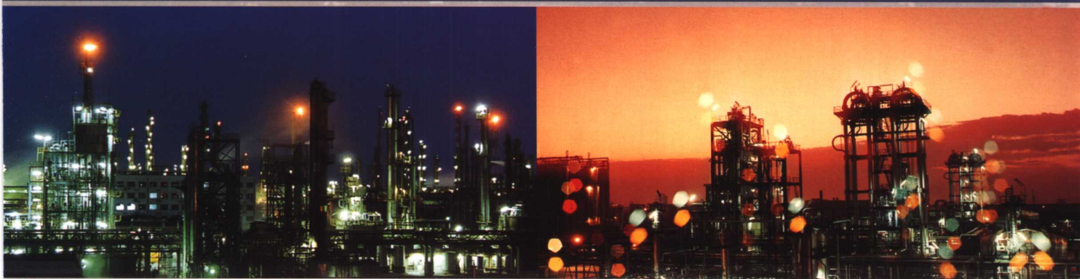
公司化工事业部6.5万吨丙烯晴装置
