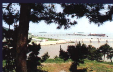
公司三个5万吨级泊位的原油码头
