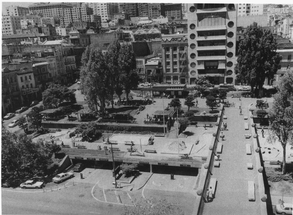
图1-7 旧金山的朴次茅斯广场是这座城市中最早的几个城市广场之一,它由早期的西班牙殖民者兴建。20世纪50年代,人们将原有的广场改建成为一个带有新设计的屋顶花园的地下停车场。
