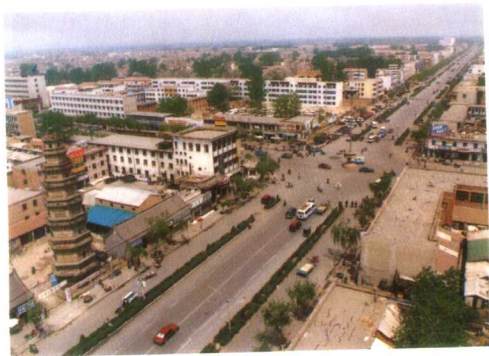
▲ 尉氏县交通局承建的县城建设路
