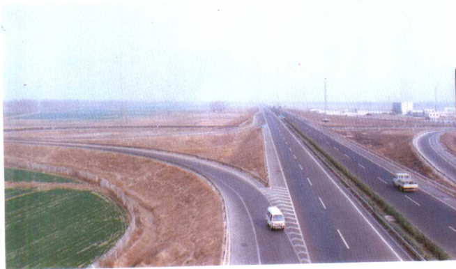
▲ 开岗大型互通式立交桥
