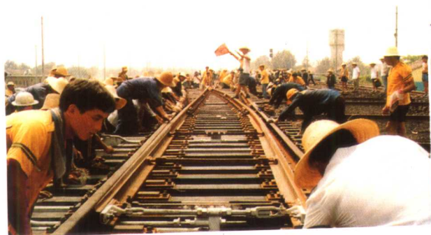
▲ 更换道岔施工现场
