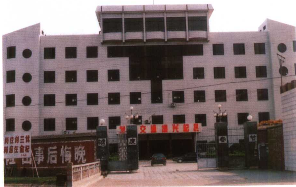
▲ 杞县交通局办公楼
