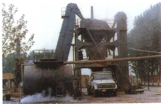
▲ 沥清拌和楼正在生产拌和料
