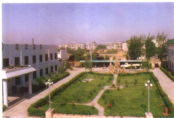
▲ 位于材料场东街的开封电务段办公大楼
