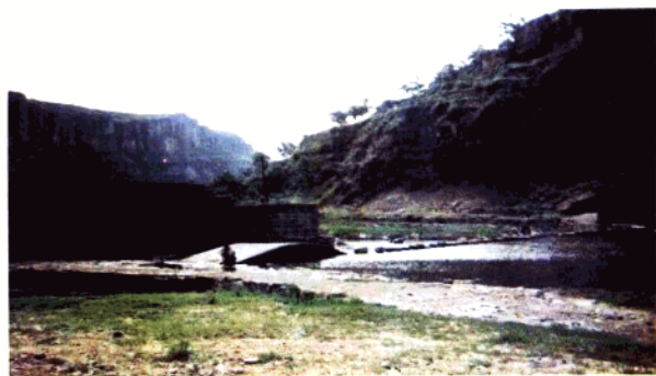
工农渠渠首进水闸、泄水闸、大坝
