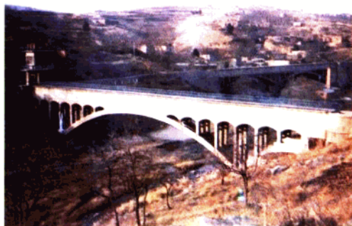
工农渠长虹渡槽
