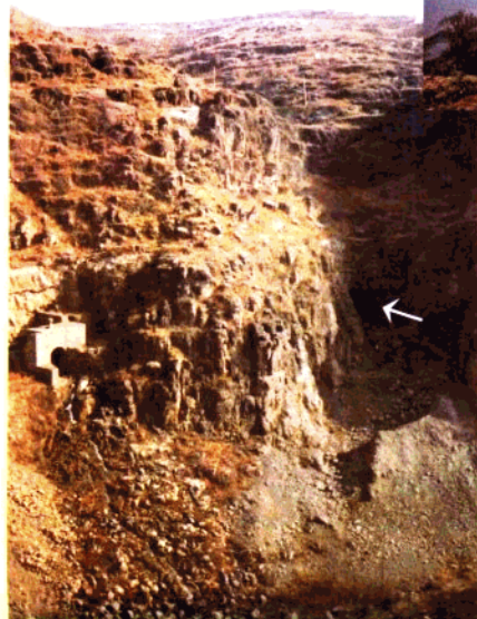
工农渠牛横岭洞进口出渣洞口
