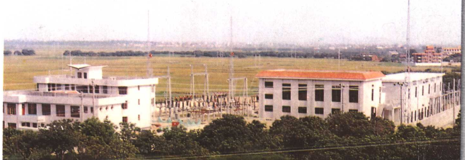
●梧塘11万伏输变电站远眺
