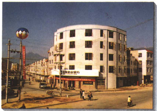
●建设银行梧塘分理处营业大楼
