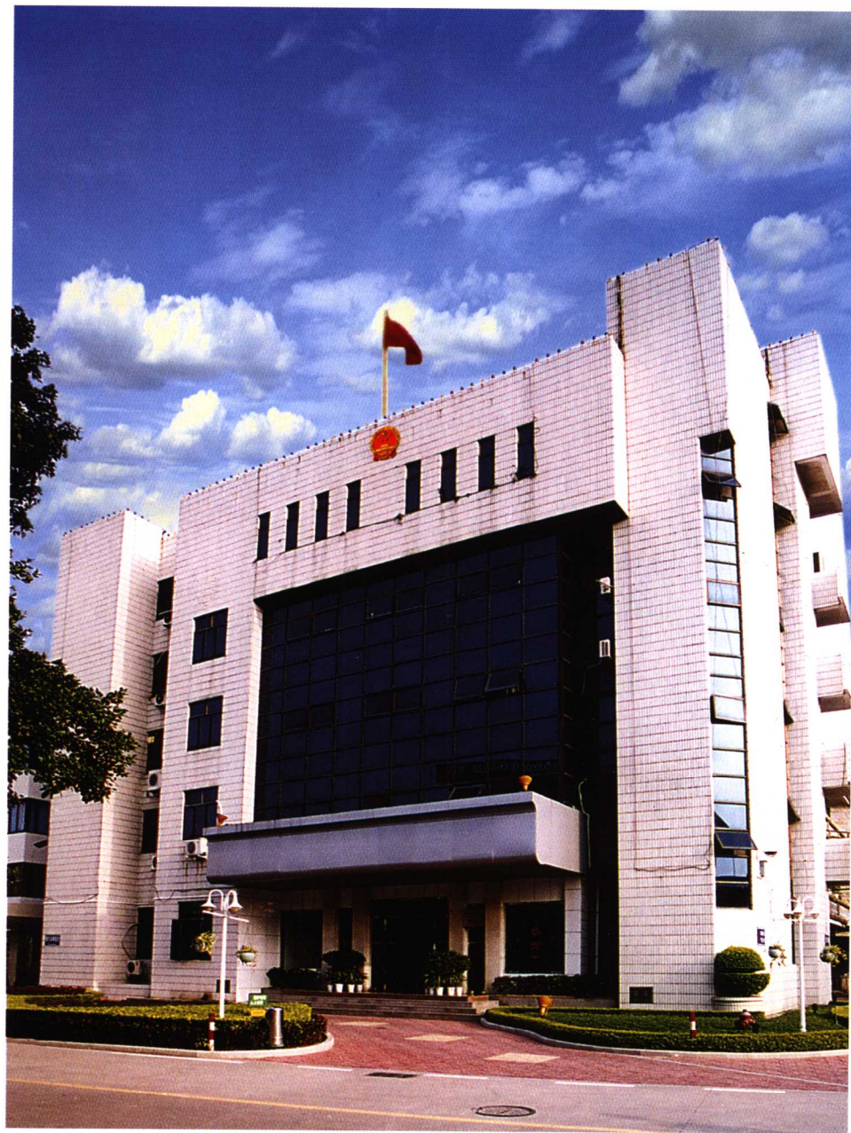
▲ 晋江市人大常委会办公大楼
