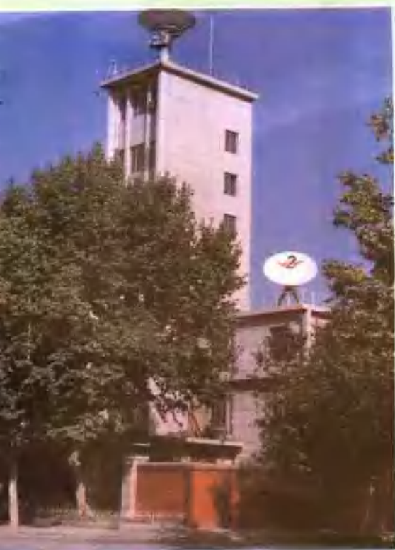
河南省气象台办公楼
