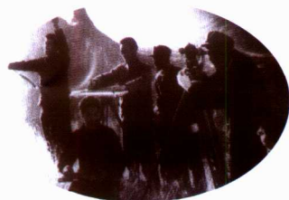
跃进渠建设中的科技人员在精心工作(1968年)
