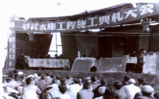
1958年，彰武水库工程开工典礼
