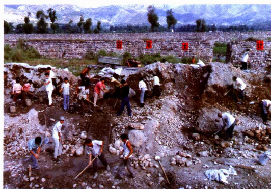
漳河护岸工程工地（2004年）
