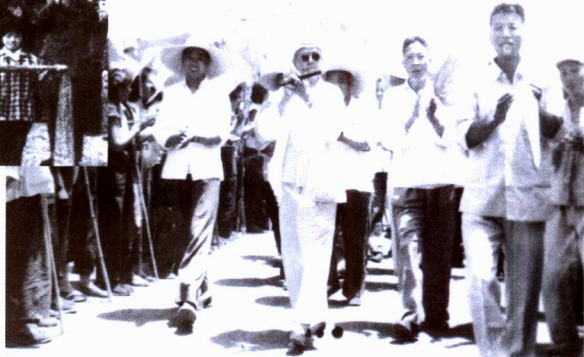
1959年，河南省副省长贾心斋（中）到南海水库工地慰问建设大军
