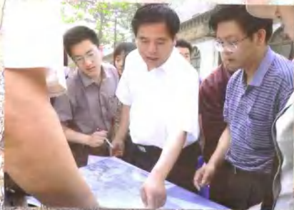
副市长倪豫州（中）在背街小巷治理工地上
