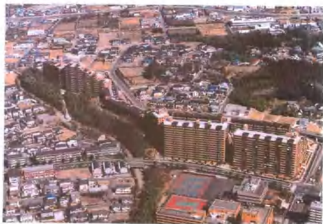
建筑用地全景。沿着下穿公路的小溪沿岸的斜坡林是“菲利亚森林”
