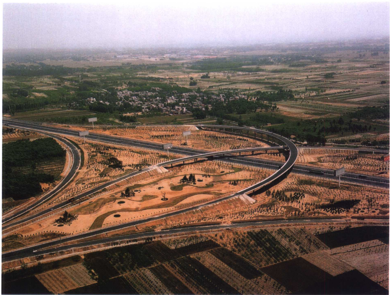
京珠互通立交桥——郑州西南绕城高速公路与京珠高速公路相交
