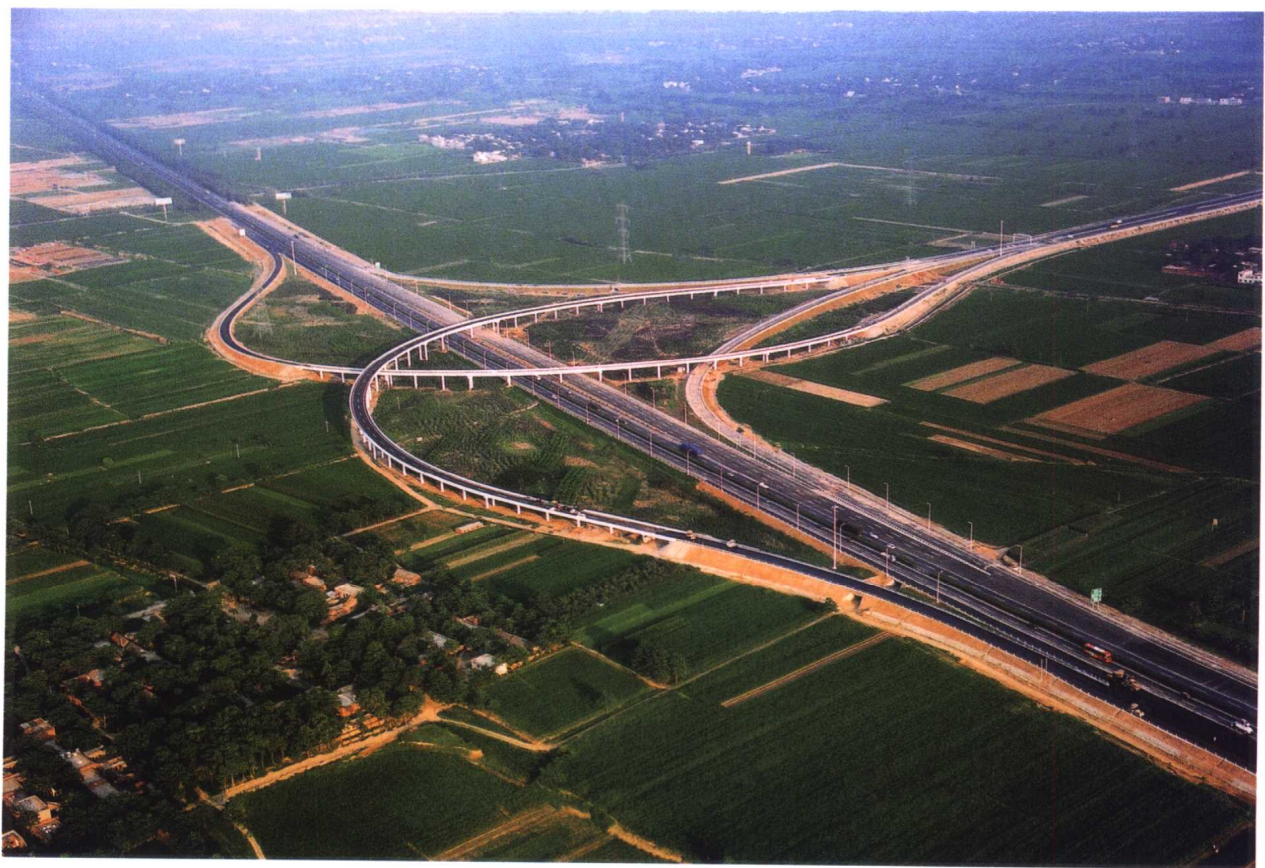
连霍互通立交桥——郑州西南绕城高速公路与连霍高速公路相交
