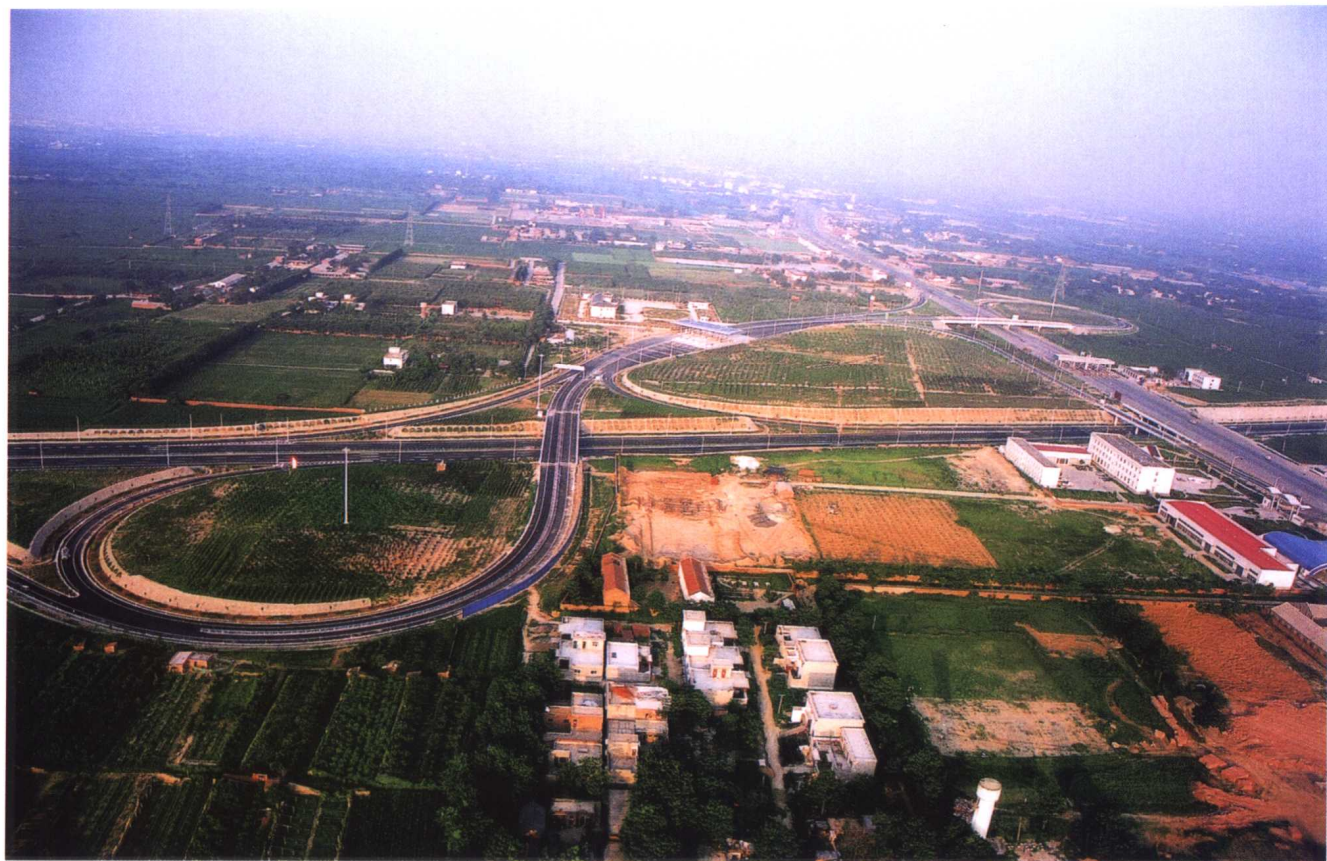
310 互通立交桥——郑州西南绕城高速公路与 310 国道相交
