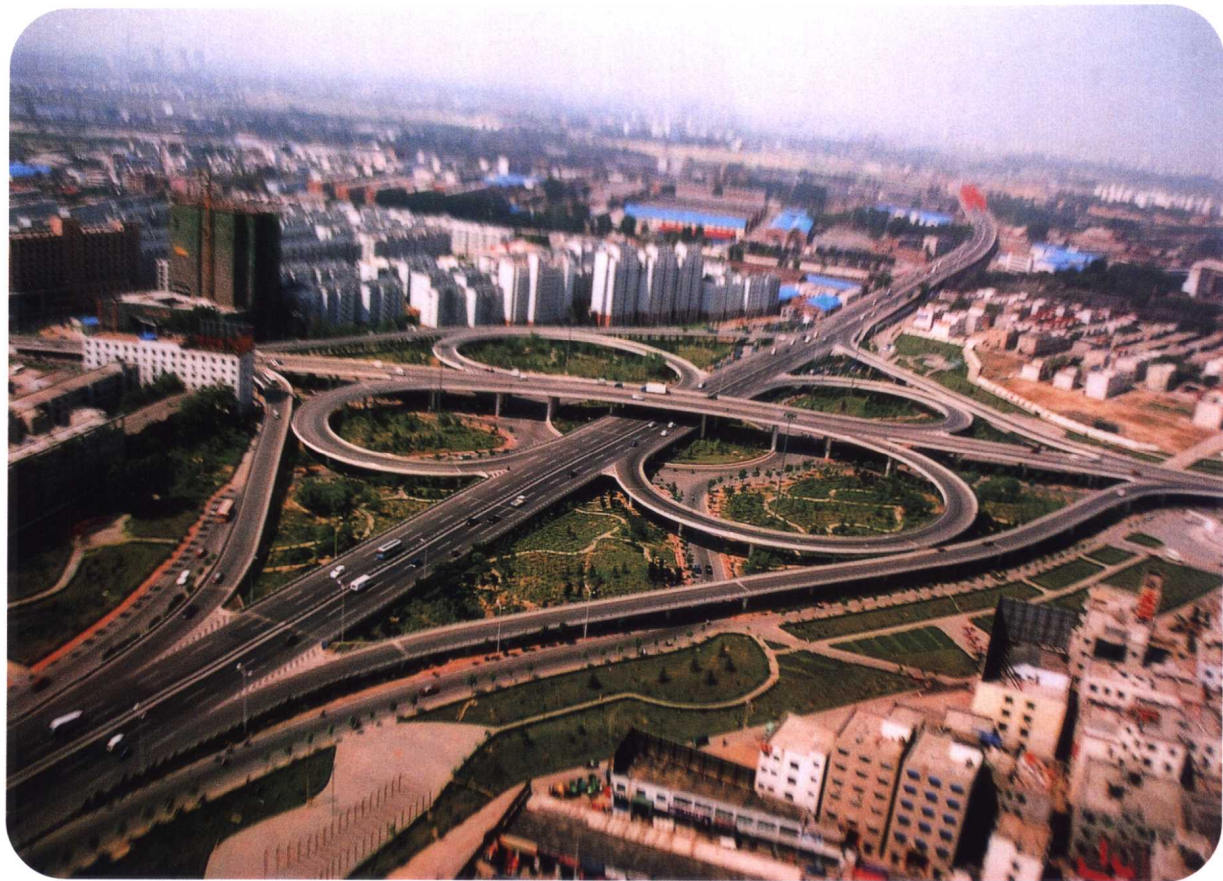
南阳路立交桥
